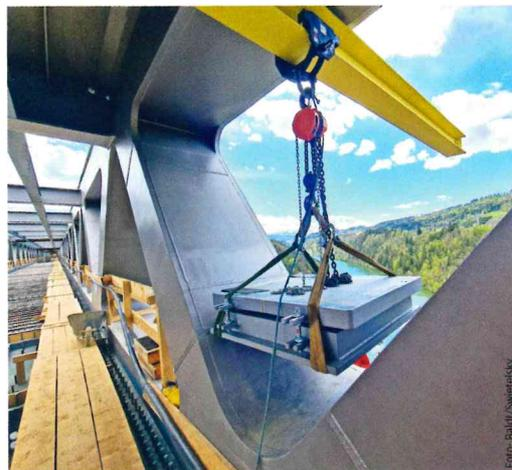
Über seitlich aus dem Tragwerk ragende Portalkrane wurden die 12 Lager, die ein Gewicht von 570 kg bis 2.600 kg aufweisen, eingebaut und danach das Tragwerk abgesenkt.
