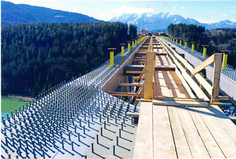
Das Tragwerk weist zwei Brückendecks auf. Sowohl das obenliegende Eisenbahndeck (links) als auch das untenliegende Brückenunterdeck (rechts), welches als Geh- und Radwegdeck genutzt wird, sind als Verbundfahrbahnplatte konzipiert.
