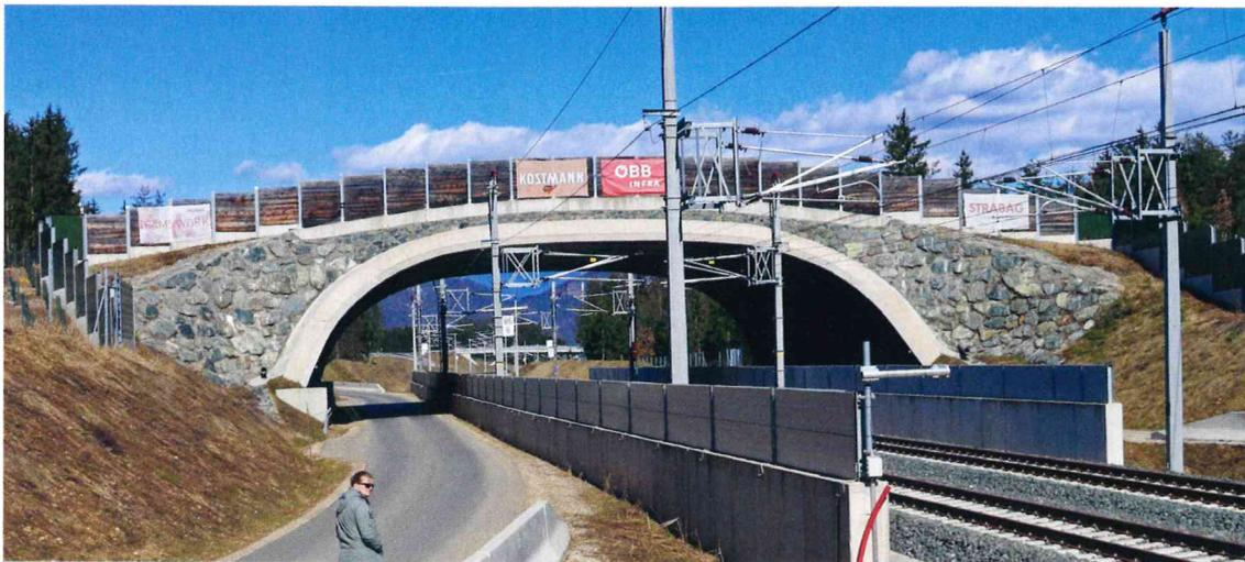
Auch in anderen Bereichen setzt ÖBB-Infrastruktur AG auf effiziente und ressourcenschonende Lösungen. Südlich der Jauntalbrücke wurde bei Aich diese Wildwechselbrücke errichtet, indem in Zusammenarbeit mit der TU Wien die Betonschale durch ein aufblasbares Luftpolster gehoben wurde. Die vorne und hinten abgeschnittene Kuppel wurde so zur Brücke.
